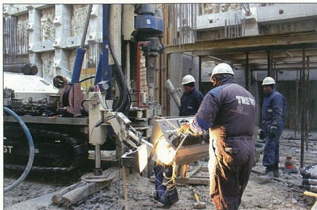
Data la particolare geologia locale, la perforazione è stata eseguita ad aria compressa utilizzando un martello a fondo foro per tutta la profondità
