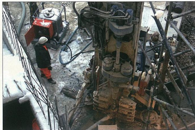
La PSM-16GT è stata allestita con un preventer in grado di convogliare i detriti di perforazione senza disperderli nell'ambiente circostante.
