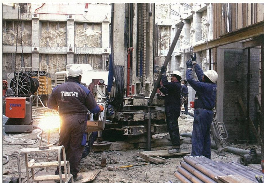
La velocità raggiunta in fase di perforazione (20 m/h) e l'ottimizzazione delle fasi di posa sonda, cementazione e collaudo hanno consentito di rispettare i tempi previsti
