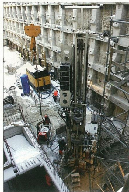
Per collocare la perforatrice sul piano di lavoro, situato a quota -9 m dal piano stradale, è stato necessario sollevare la perforatrice mediante un'autogrù da 300 t
