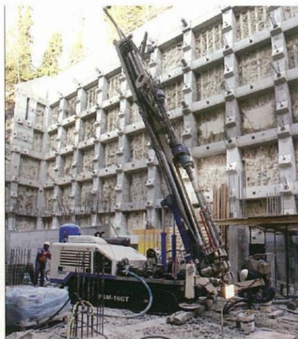
La limitatezza degli spazi di lavoro ha determinato la scelta della PSM-16GT, macchina agile e al tempo stesso in grado di gestire perforazioni ad alta profondità
