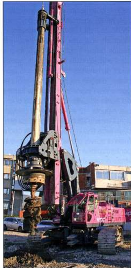
Il sistema di spinta è composto da un cilindro idraulico con corsa di 6,5 m e due posizioni di fissaggio sul carrello della rotary
