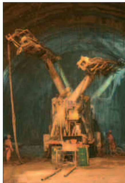
Il consolidamento delle gallerie procede per campi di 6 m e viene eseguito tramite infilaggi in vetroresina e in acciaio, valvolati e non, inseriti in perforazione e iniettati in fase di scavo
