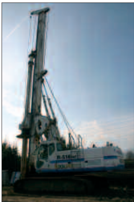
Una delle perforatrici idrauliche Soilmec R-516HD all'opera sulla tratta, incaricata dell'esecuzione di pali trivellati di grande diametro
