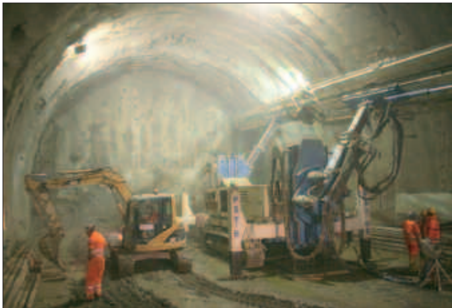
Per l'esecuzione di tutte le opere geotecniche di fondazione e consolidamento e lo scavo delle gallerie, BTP ha messo in campo un ingente parco macchine
