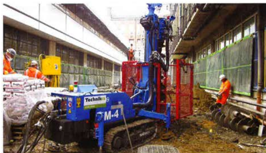
A microestaqueadora da Soilmec SM-4 foi recentemente apresentada ao mercado mundial, e serve para espaços confinados.
