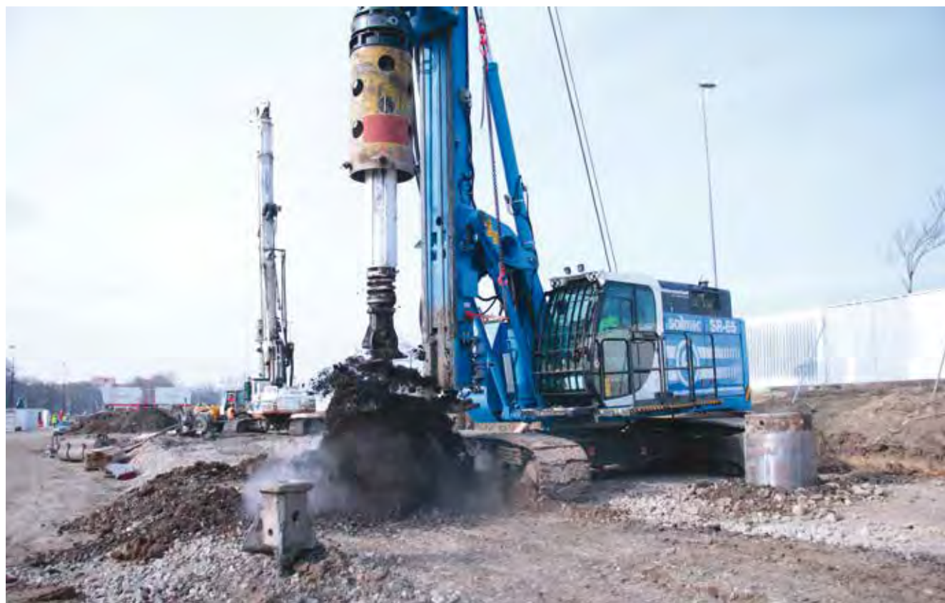
LA PRODUZIONE NEL CANTIERE DI PRAGA È STATA PARI A DUE PALI AL GIORNO PER UN TURNO DI OTTO ORE, IN UN TERRENO COMPOSTO DA ARGILLE COMPATTE CON LA PRESENZA DI STRATI MOLTO COMPATTI INTERCALATI DA GHIAIE E TROVANTI
