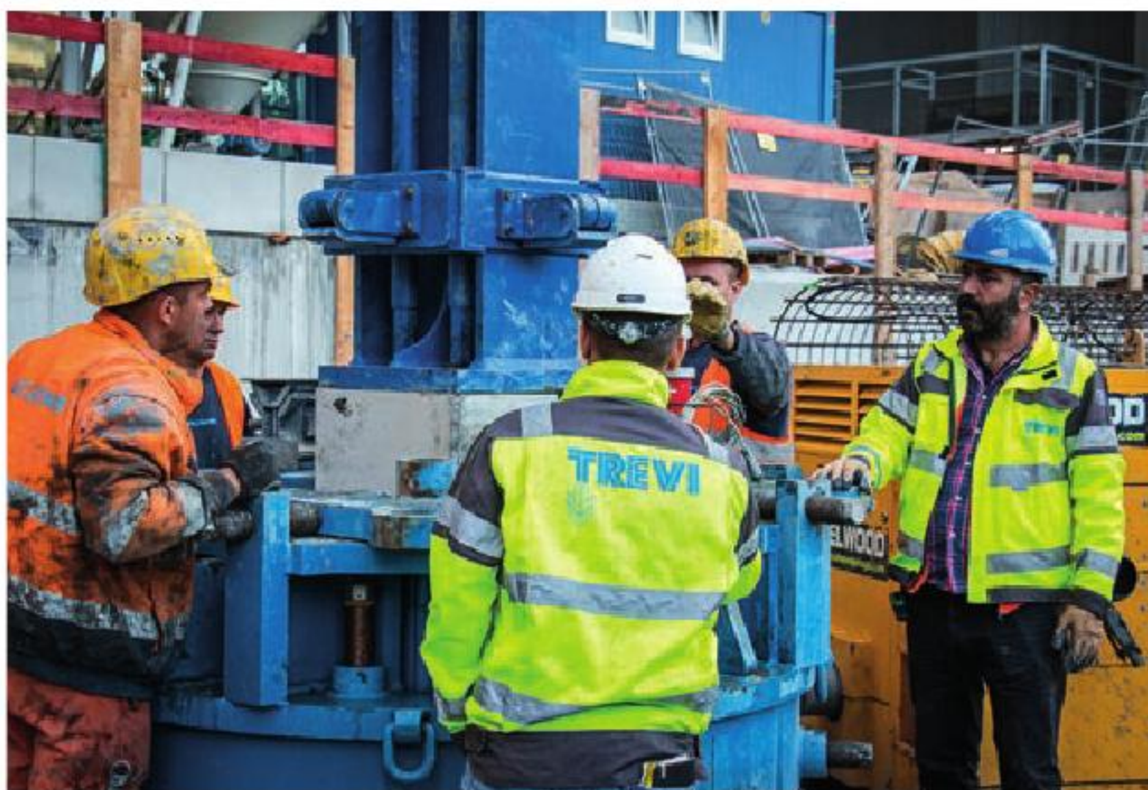
I lavori di ingegneria del sottosuolo sono stati affidati alle due divisioni Trevi Geotechnik e Trevi Spezialtiefbau
